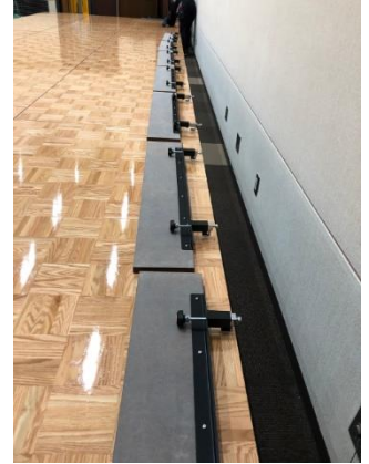
チェアストップパネルをステージ後方に 12台設置 立ち上がり200H
