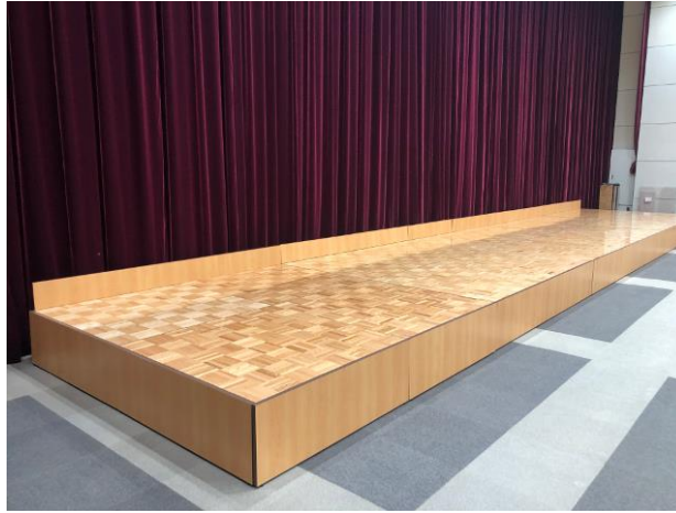
チェアストップパネルをステージ後方に 12台設置 立ち上がり200H
