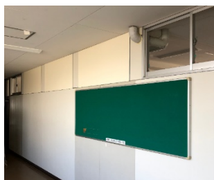
欄間ふさぎ工事
